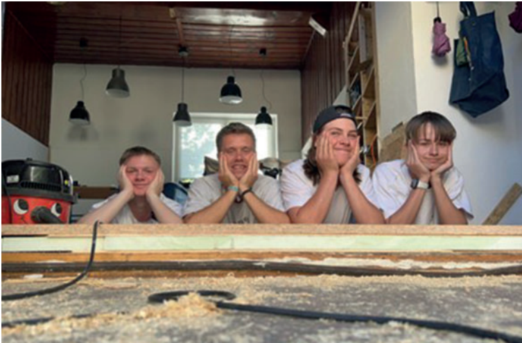
Neuer Fußboden: Styrodur, OSB Platte, Vinyl
